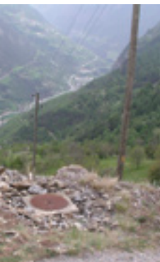
Ein Kontrollschacht – Hinweis auf die unterirdische Kanalisation
