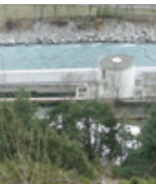
Die Kläranlage Stalden
