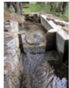
Suone mit Schieber, um das Wasser gerecht in die Verteilungskanäle zu leiten
