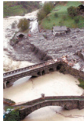
Verheerende Auswirkungen des Murganges bei Neubrück im Oktober 2000
